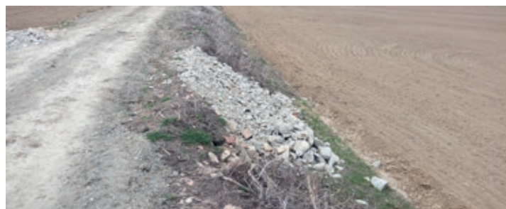
Černá skládka ze stavební suť
